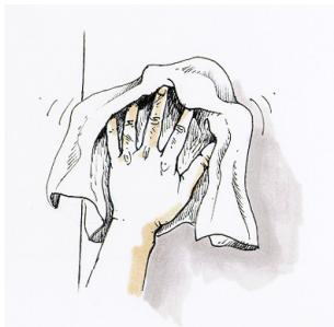
Appliquer à une température comprise entre +15 °C et +25 °C. Les surfaces doivent être propres et sèches, exemptes de poussière, de graisse, d'huile et de toute autre matière friable. Ne pas utiliser de produits dégraissants. Ne pas utiliser dans des applications susceptibles d'entrer en contact avec des solvants chlorés, cétoniques ou esters.
